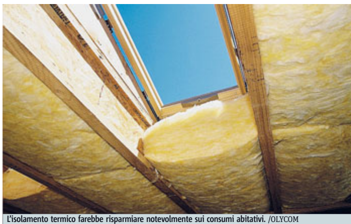
L'isolamento termico farebbe risparmiare notevolmente sui consumi abitativi. /OLYCOM
