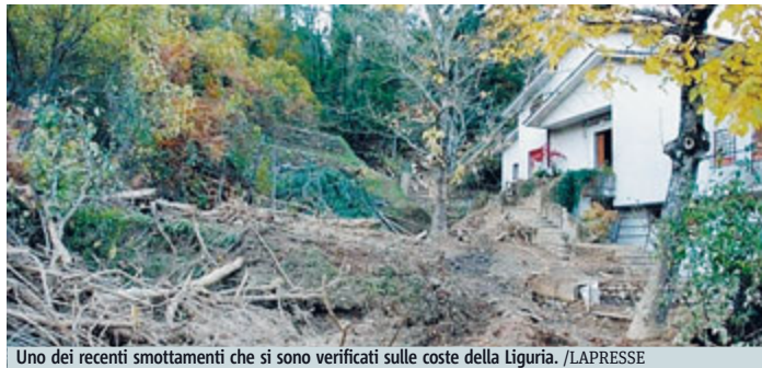
Uno dei recenti smottamenti che si sono verificati sulle coste della Liguria. /LAPRESSE
