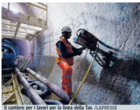
Il cantiere per i lavori per la linea della Tav. /LAPRESSE
