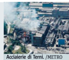
Acciaierie di Terni. /METRO
