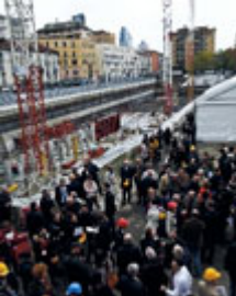
Il cantiere. PHOTOVIEWS
