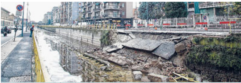
Un pezzo di argine e strada franato lungo l'alzaia Naviglio Pavese, all'altezza di via Rimini / FOTO FOTOGRAMMA
