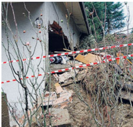
La frana sulla casa di Laveno. /DANIELE BELOSIO-VARESE PRESS
