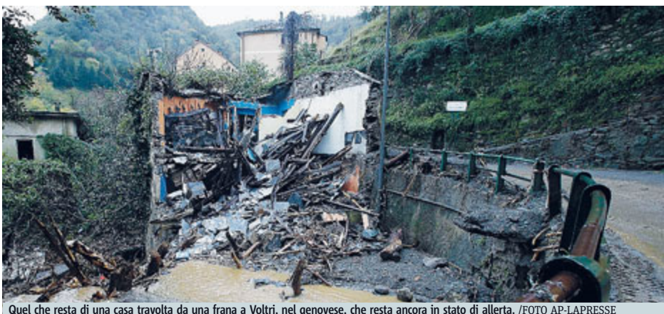
Quel che resta di una casa travolta da una frana a Voltri, nel genovese, che resta ancora in stato di allerta. /FOTO AP-LAPRESSE
