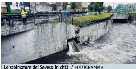
Lo scolmatore del Seveso in città. / FOTOGRAMMA
