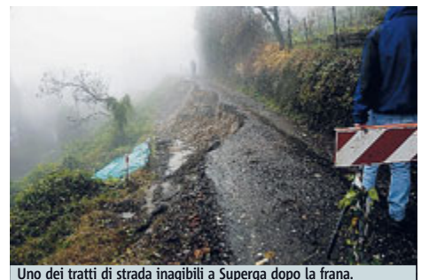
Uno dei tratti di strada inagibili a Superga dopo la frana.
