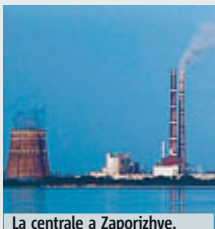
La centrale a Zaporizhye.
