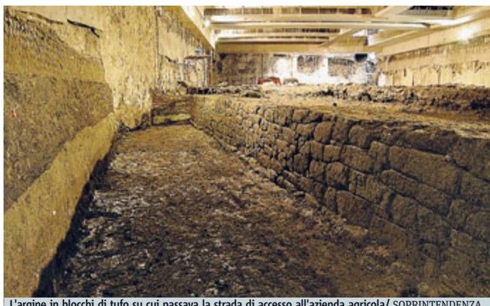
L'argine in blocchi di tufo su cui passava la strada di accesso all'azienda agricola/ SOPRINTENDENZA
