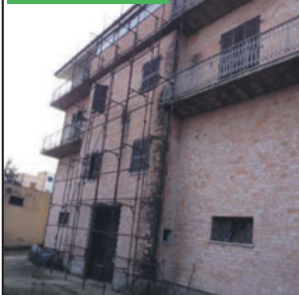
ANAGNINA - TUSCOLANA Ristrutturazione fabbricato
