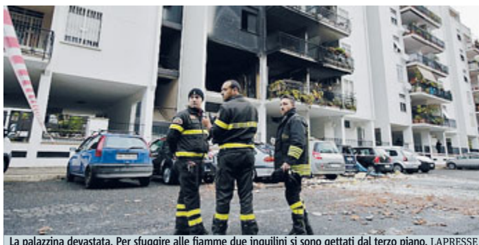
La palazzina devastata. Per sfuggire alle fiamme due inquilini si sono gettati dal terzo piano. LAPRESSE
