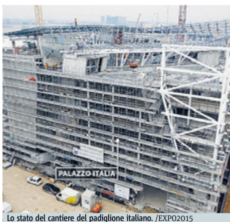
Lo stato del cantiere del padiglione italiano. /EXPO2015
