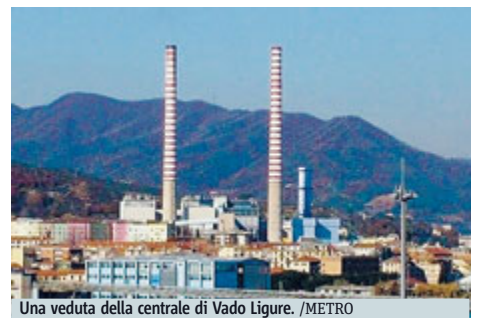
Una veduta della centrale di Vado Ligure. /METRO
