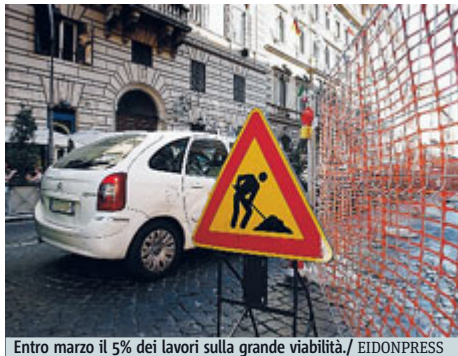
Entro marzo il 5% dei lavori sulla grande viabilità. / EIDONPRESS
