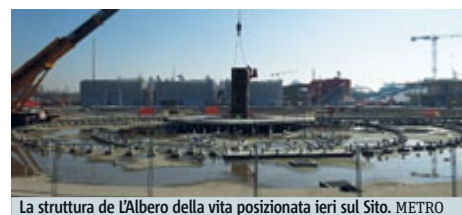
La struttura de l'Albero della vita posizionata ieri sul Sito. METRO
