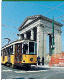
Il cantiere. PHOTOVIEWS
