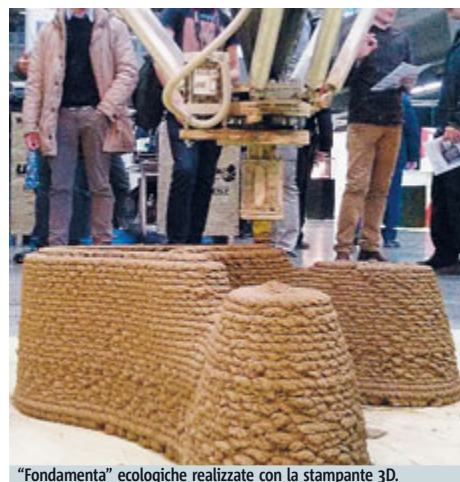
"Fondamenta" ecologiche realizzate con la stampante 3D.
