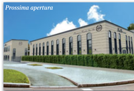
Milano, via Corelli, 120
