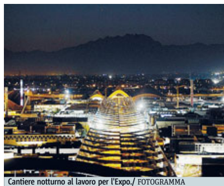
Cantiere notturno al lavoro per l'Expo./ FOTOGRAMMA
