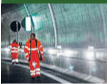
Il cantiere della Pedemontana. FOTOGRAFMA
