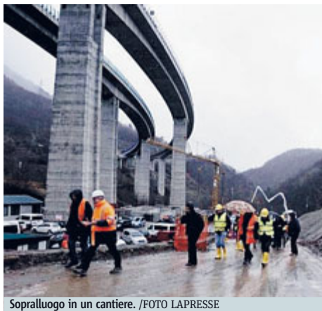
Sopraluogo in un cantiere. /FOTO LAPRESSE
