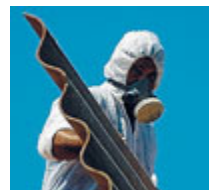
Bonifica in corso. /OLYCOM
