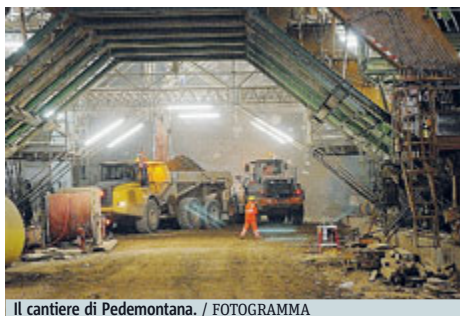
Il cantiere di Pedemontana. / FOTOGRAMMA
