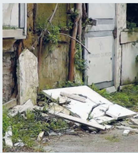
Degrado nel cimitero monumentale di Poggioreale. /METRO
