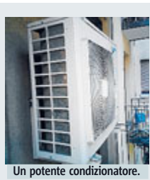
Un potente condizionatore.
