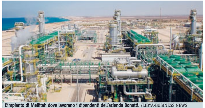
L'impianto di Mellitah dove lavorano i dipendenti dell'azienda Bonatti. /LIBYA-BUSINESS NEWS
