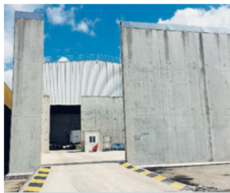
NUOVA CELLA IN COSTRUZIONE A L'AUBE
