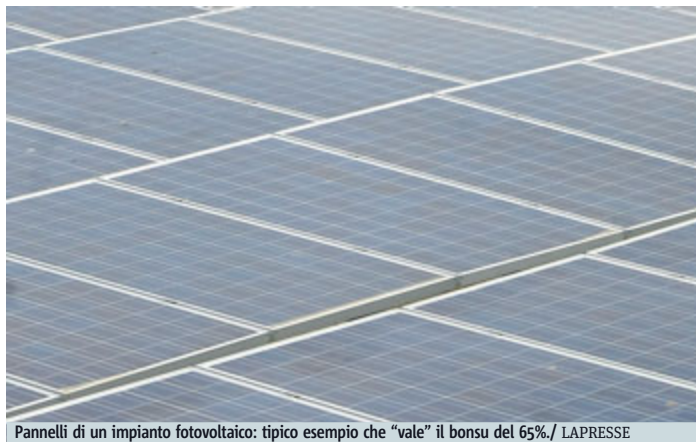
Pannelli di un impianto fotovoltaico: tipico esempio che "vale" il bonus del 65%/ LAPRESSE
