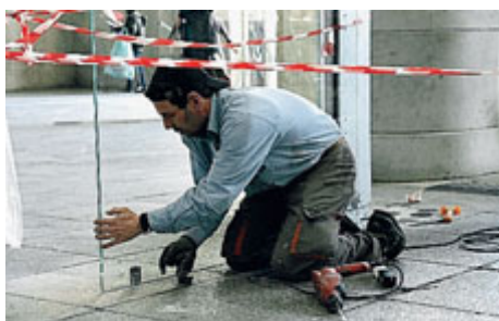
Un lavoratore all'opera alla Stazione Centrale. FOTOGRAMMA
