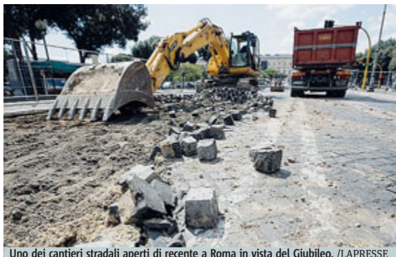
Uno dei cantieri stradali aperti di recente a Roma in vista del Giubileo. /LAPRESSE
