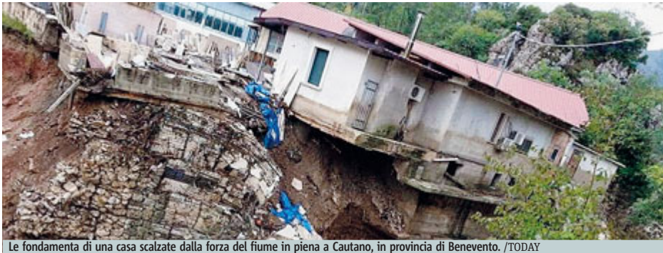
Le fondamenta di una casa scalzate dalla forza del fiume in piena a Cautano, in provincia di Benevento. /TODAY
