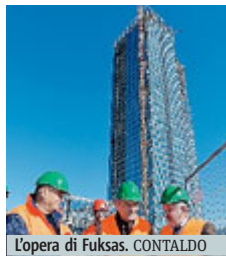
L'opera di Fuksas. CONTALDO
