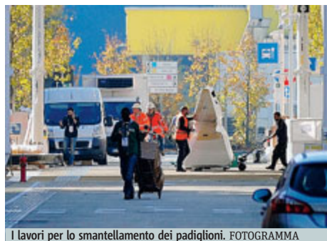
I lavori per lo smantellamento dei padiglioni. FOTOGRAMMA
