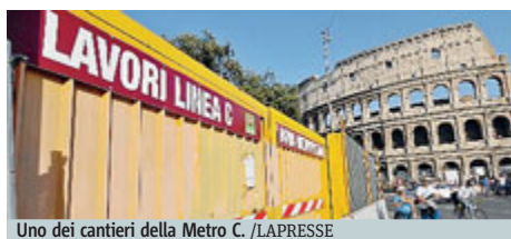
Uno dei cantieri della Metro C. /LAPRESSE
