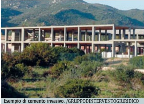
Esempio di cemento invasivo. /GRUPPOINTERVENTOGIURIDICO
