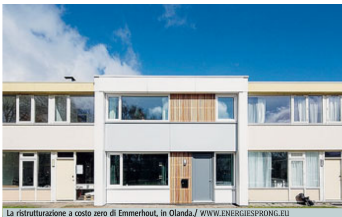
La ristrutturazione a costo zero di Emmerhout, in Olanda./ WWW.ENERGIESPRONG.EU
