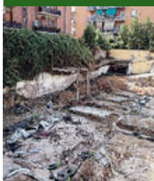
L'area del crollo. /EIDON
