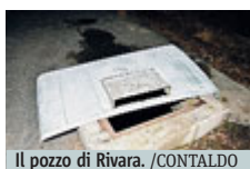
Il pozzo di Rivara. /CONTALDO
