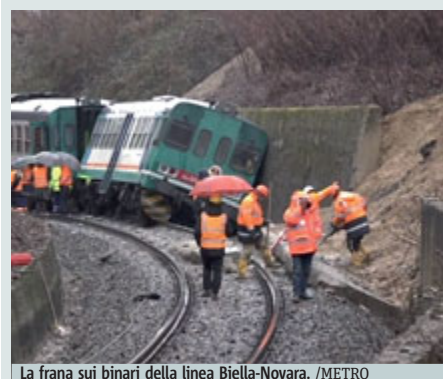
La frana sui binari della linea Biella-Novara. /METRO
