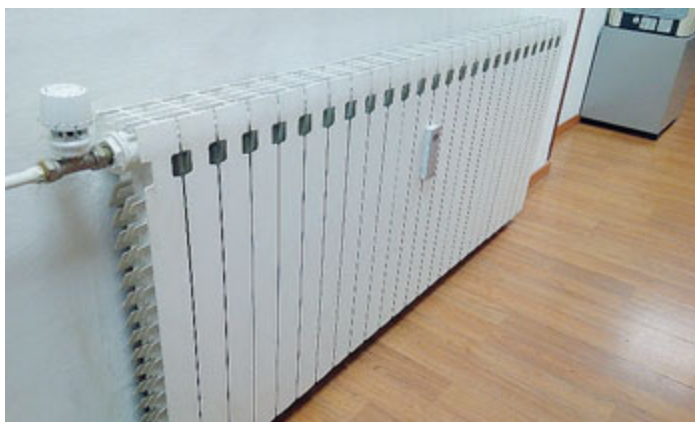
Un calorifero con i più recenti dispositivi di termoregolazione e contabilizzazione del calore./ METRO
