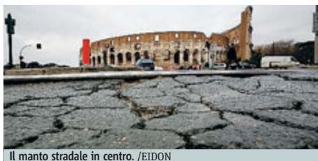
Il manto stradale in centro. /EIDON
