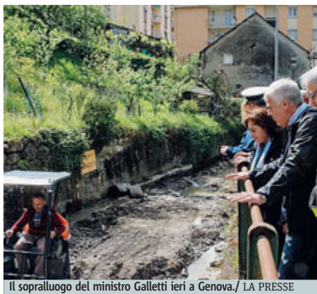
Il sopralluogo del ministro Galletti ieri a Genova. / LA PRESSE
