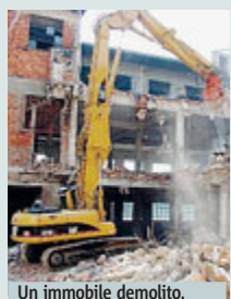
Un immobile demolito.
