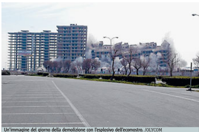
Un'immagine del giorno della demolizione con l'esplosivo dell'ecomostro. /OLYCOM
