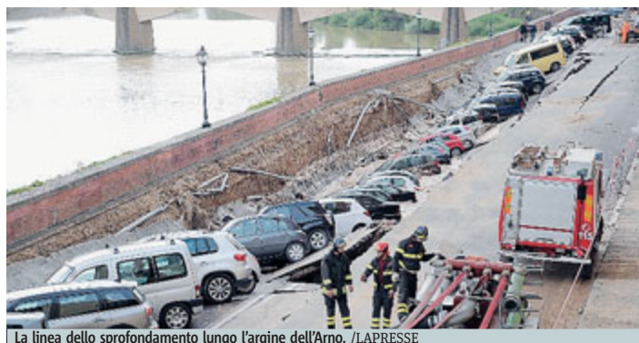
La linea dello sprofondamento lungo l'argine dell'Arno. /LAPRESSE
