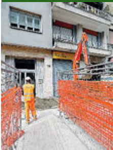
I lavori in via Foppa. FOTOGRAMMA
