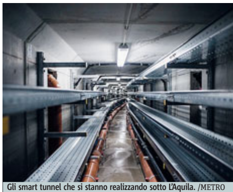
Gli smart tunnel che si stanno realizzando sotto L'Aquila. /METRO
