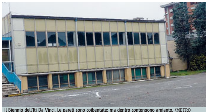
Il Biennio dell'Iti Da Vinci. Le pareti sono coibentate: ma dentro contengono amianto. /METRO
